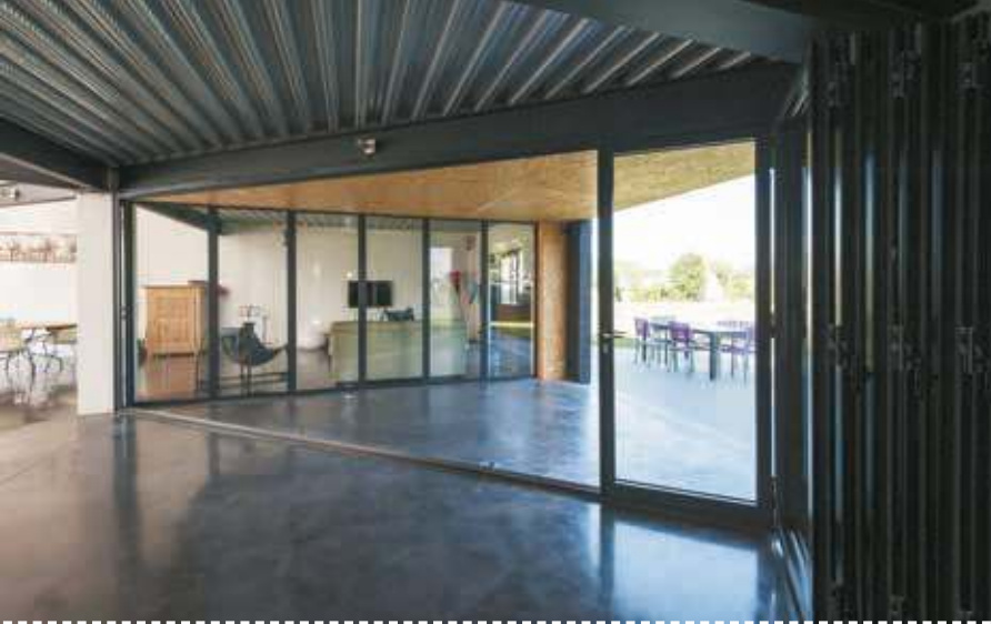
Système porté avec chariots brevetés
